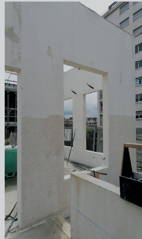
Le béton brut de la façade a été bouchardé pour accentuer l'effet de pleins et de vides. Chaque détail constructif, tels les appuis de fenêtre, affirme cette expression.
